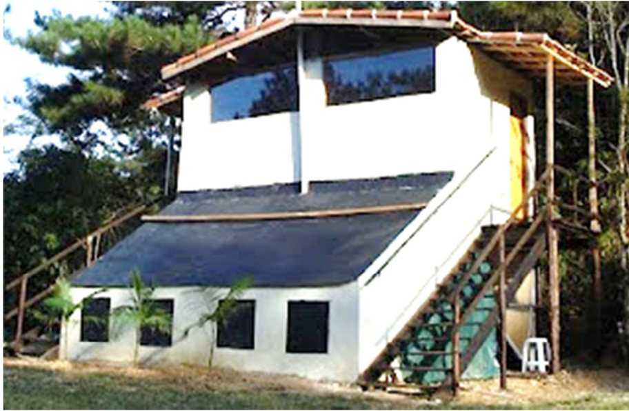
Sanitário com 4 câmaras de compostagem
