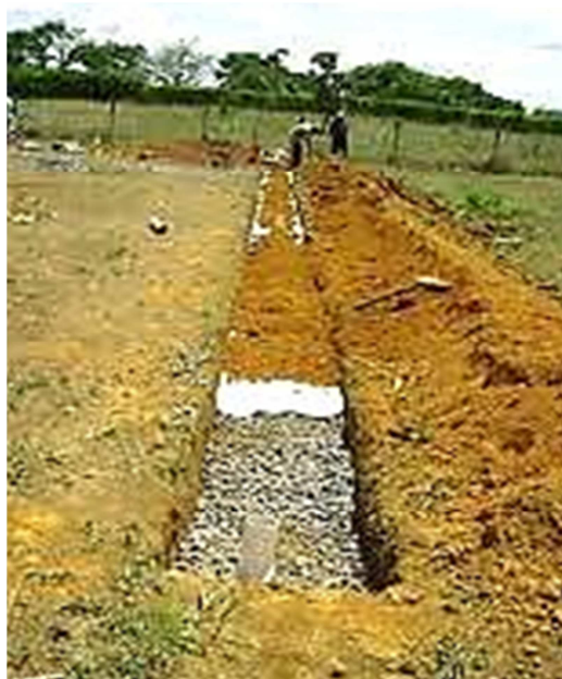
Vala em construção
