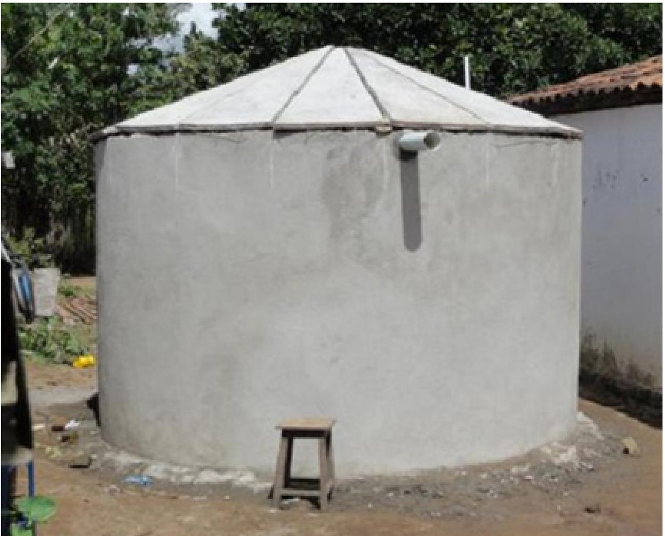
**Figura 8.** Cisterna de ferrocimento com tela de alambrado.
